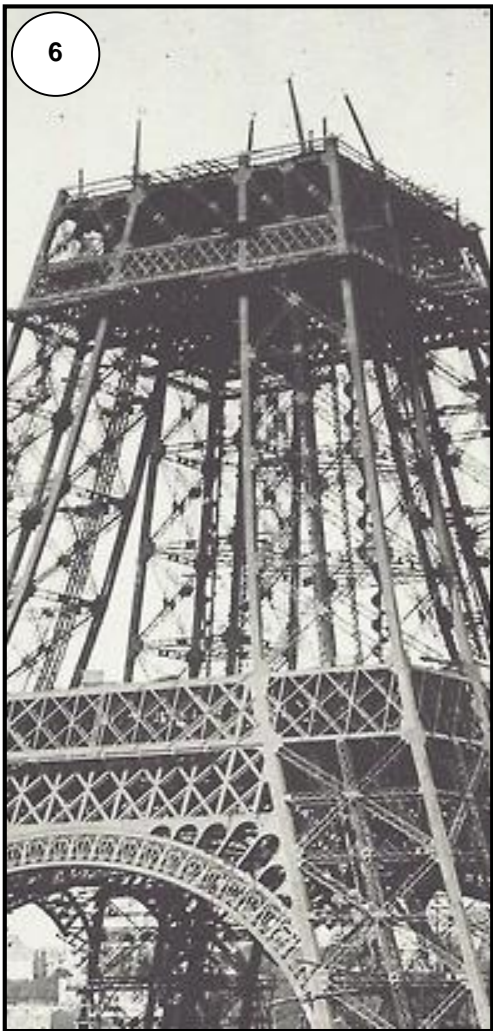
6. Construction de la Tour Eiffel, Montage de la deuxième plateforme, Paris, 1888.
